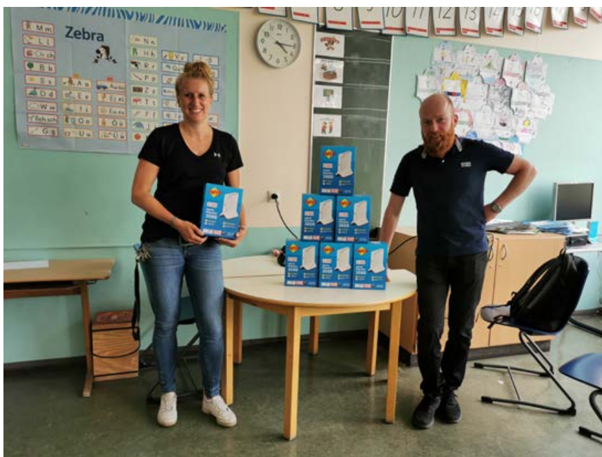
Alina Fröhlich en Steffen Piech bij de installatie van de nieuwe FRITZ!Repeaters.
